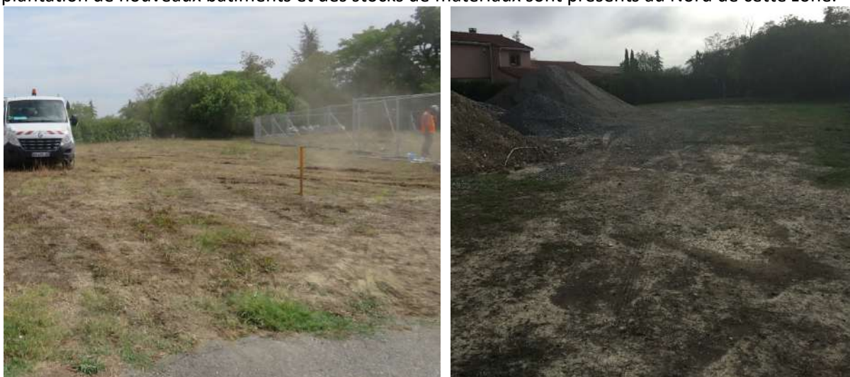
Zone rudérale en cours de travaux (à gauche) et zone de stockage des matériaux (à droite) (photographies prises le 7 septembre et le 12 octobre)
