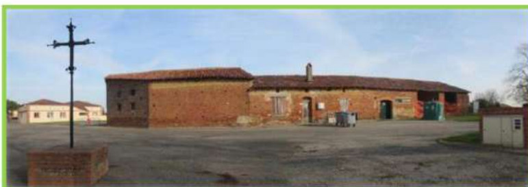
Façade principale de l'ancienne ferme et espace public situé à l'avant
