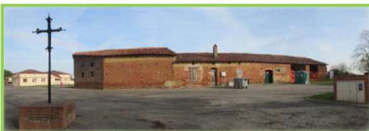
Ancien corps de ferme avant démolition
